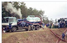
図21 強力吸引車 三國安島地区
