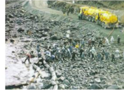
図22 1月13日仮設道路(2号道路)を建設し、漂着油を直接回収するとともに、船首部からの回収に備えた。
