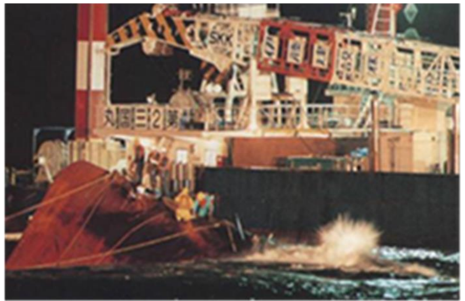
図49 2月8日23時頃 作業船による抜き取り作業 海が平穏な時に4回・8日間で2,800klの抜き取り が行われた。
