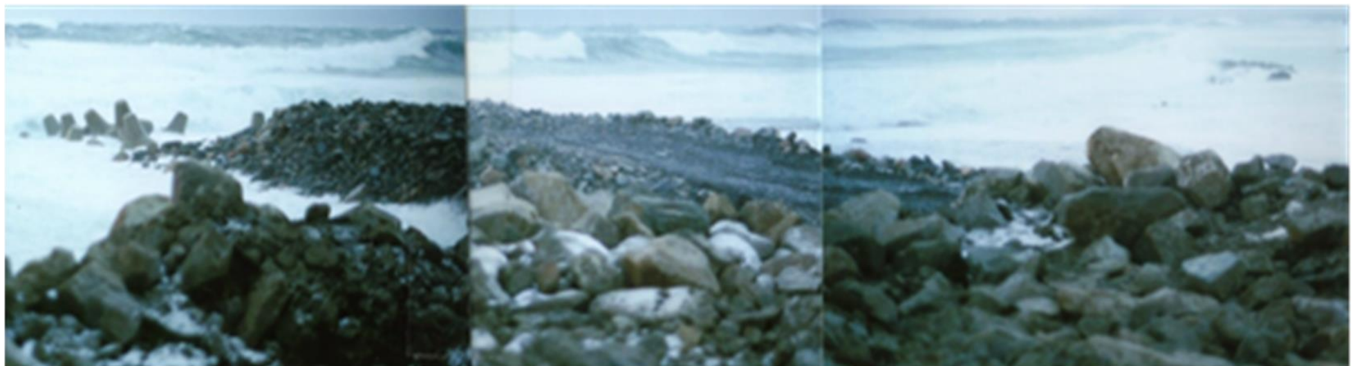
図50 1月23日 時化で建設作業中止。仮 設道路は90m進出したが、先端波で崩落、 船首部も移動した状態である。
