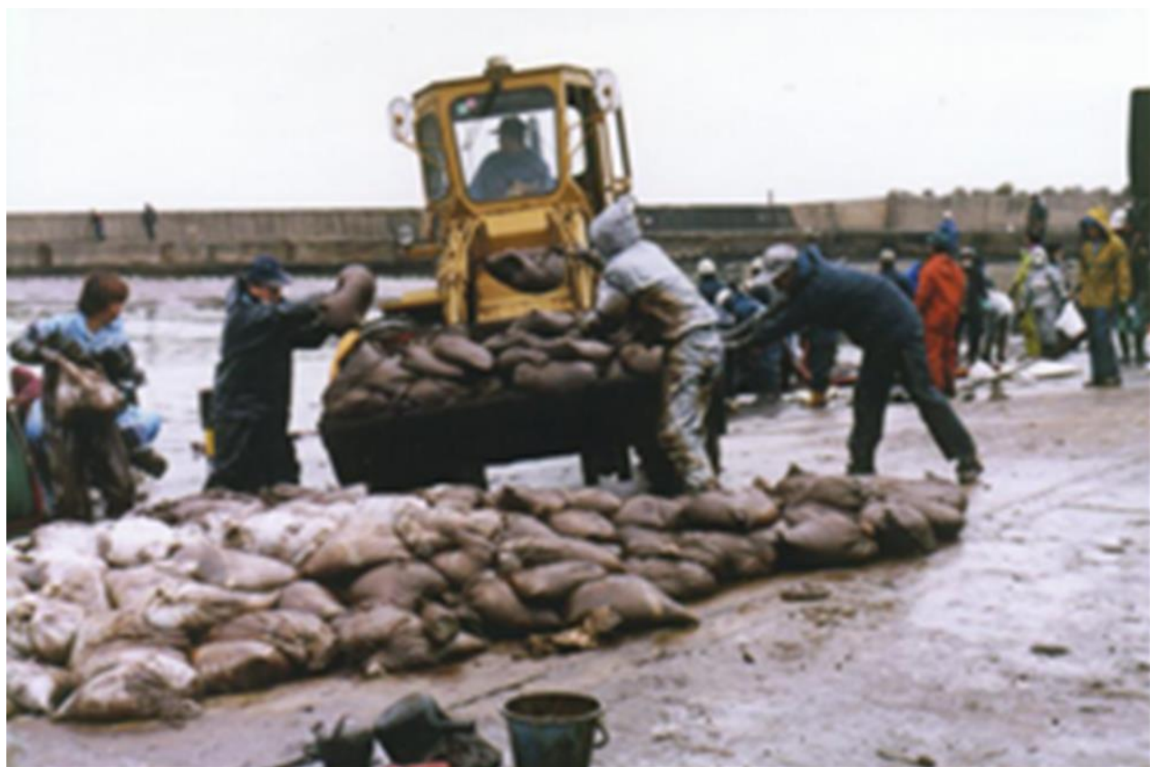
図56 土嚢はシャベルカーで長橋 のピット(図39)に運ばれた。
