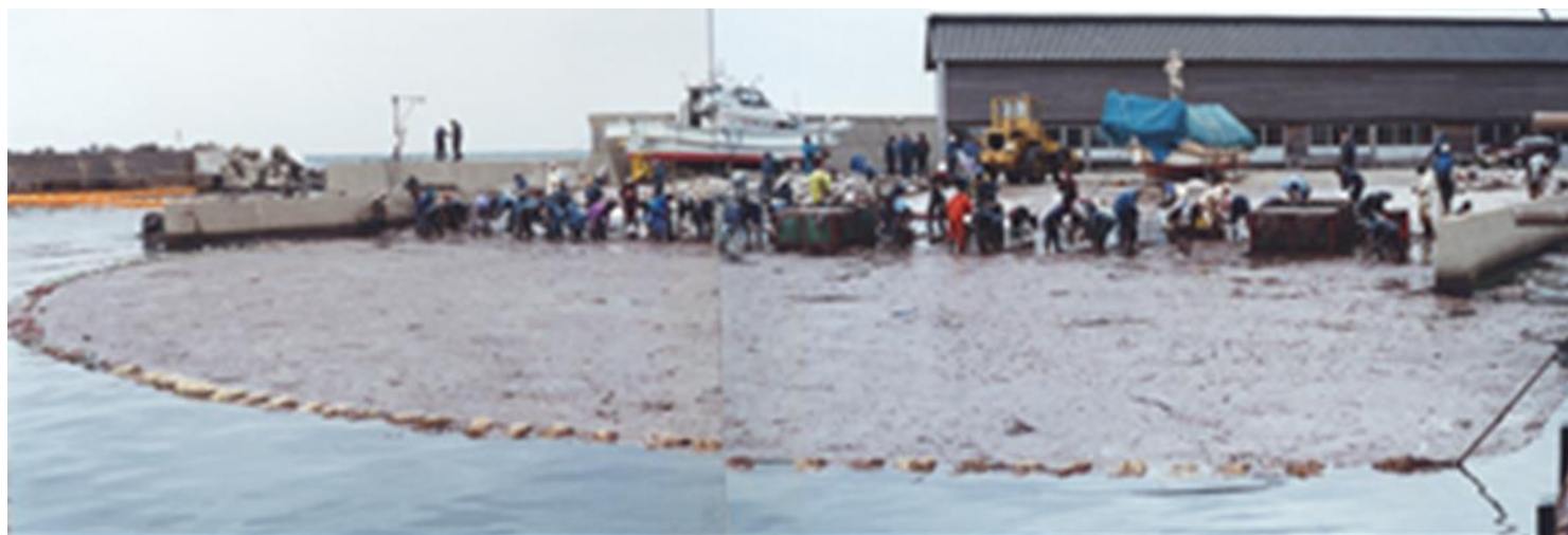
図54 1月18日の作業 スネアーで集油。奥に予定 したOFが見える。
