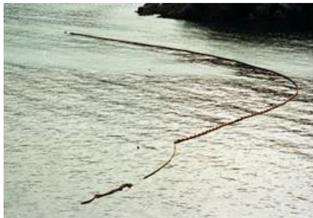
図19 漁港の湾 南北に展張された状態。風向きにより左右に振れて油が集まるなど様々の工夫がされていた。
