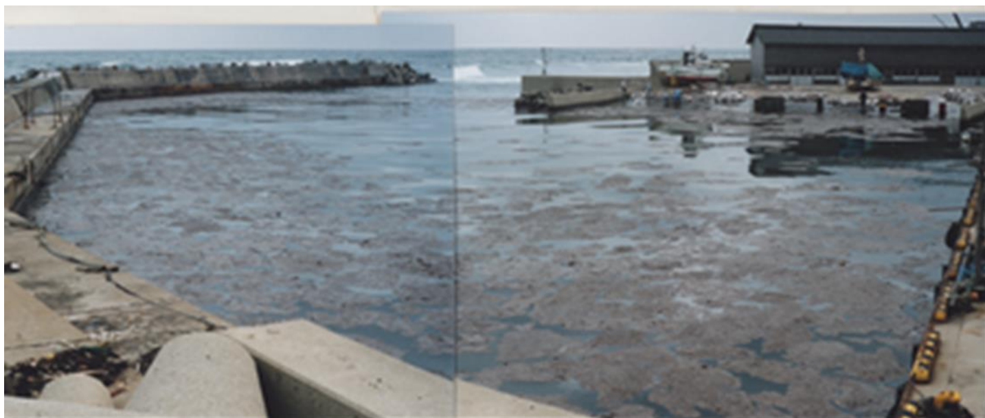
図53 1月17日 珠洲市長橋漁港の状況
