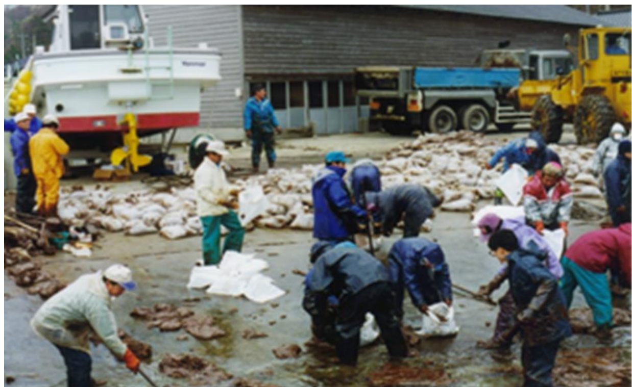
図55 集めた油は手作業で土嚢袋に入 れられた。強力吸引車で回収しよ うとしたが、ここでは拒絶された。
