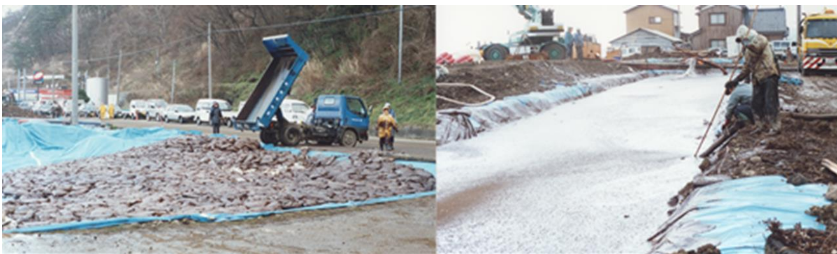
図39、40 珠洲市長橋地区 図40は図29と同じピット
