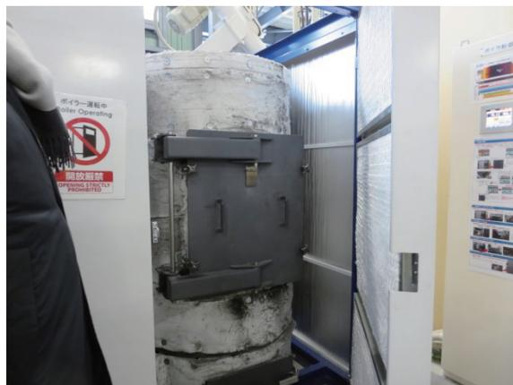
図 4.2 設置されたボイラーの燃焼部
