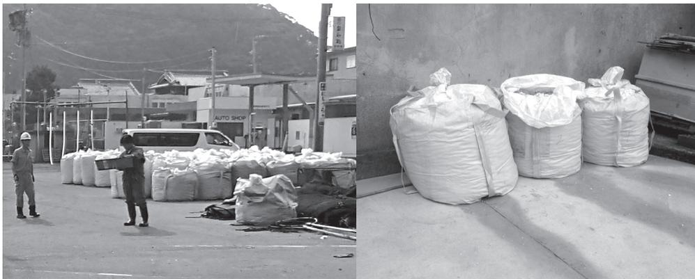
③(減容後)減容して、水分をある程度絞り出したが、減容品を入れたフレコン保管中に雨水がしみ込む。右の写真からは水がにじみ出ている。
